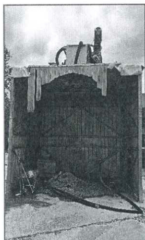
3.2.20 - Manutenzioni/ Riparazioni eseguite sui predetti componenti
